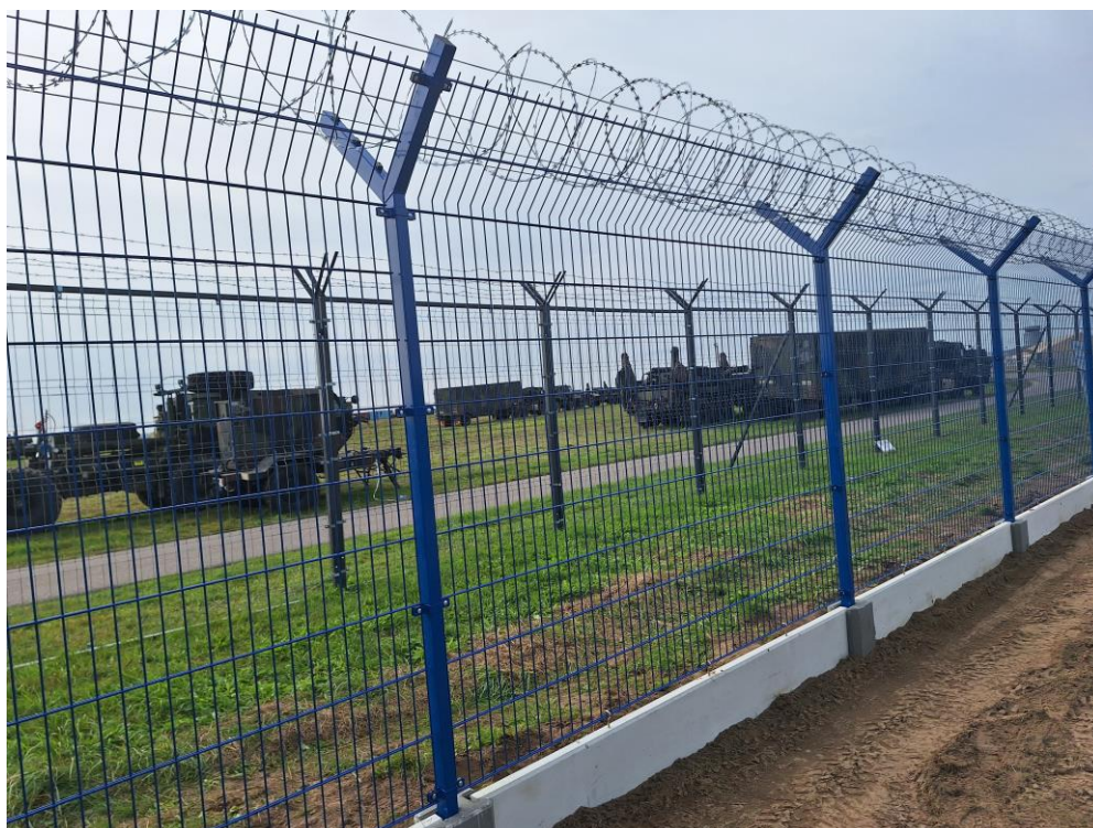
Rys. 2. Ogródzenie remontowane w 2023r.
