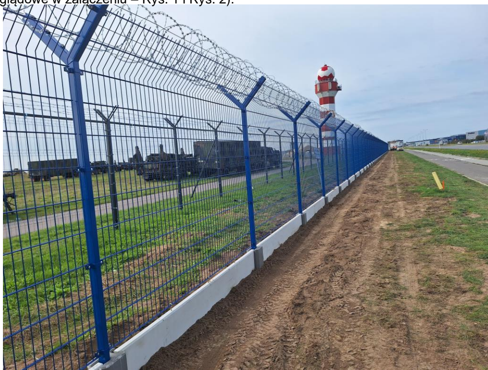
Rys. 1. Ogródzenie remontowane w 2023r.
