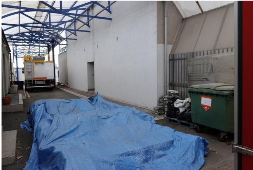
Fot. Elewacja wschodnia
