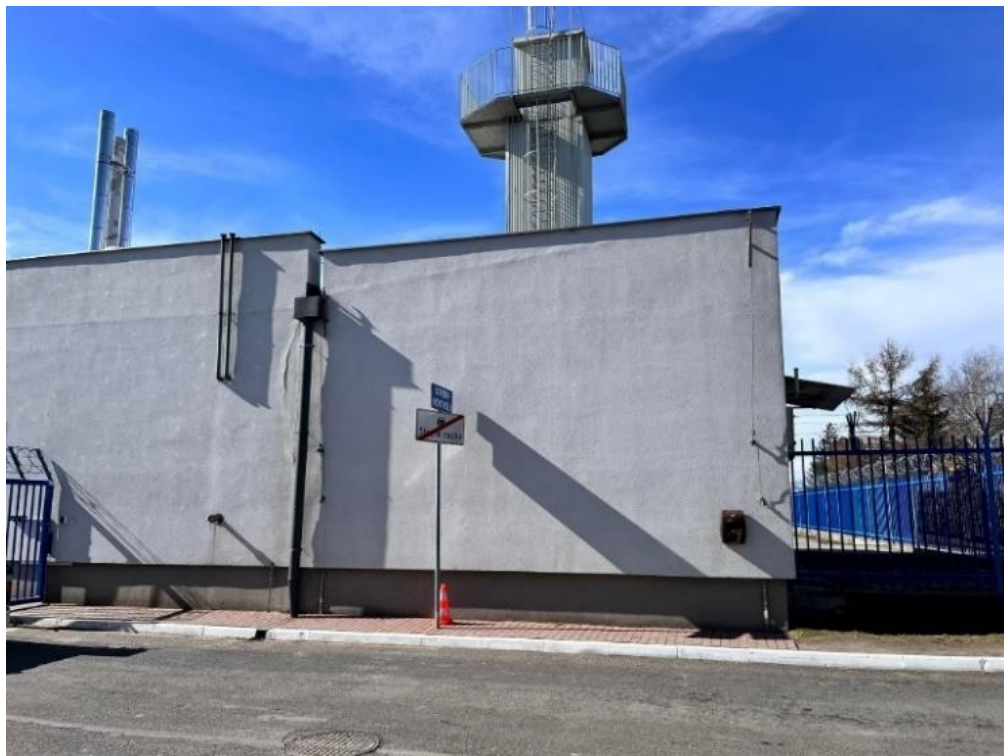
Fot. Elewacja północna cz. 1
