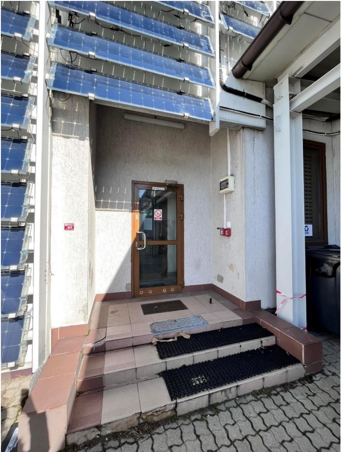
Fot. Schody wejściowe (ściana południowa)
