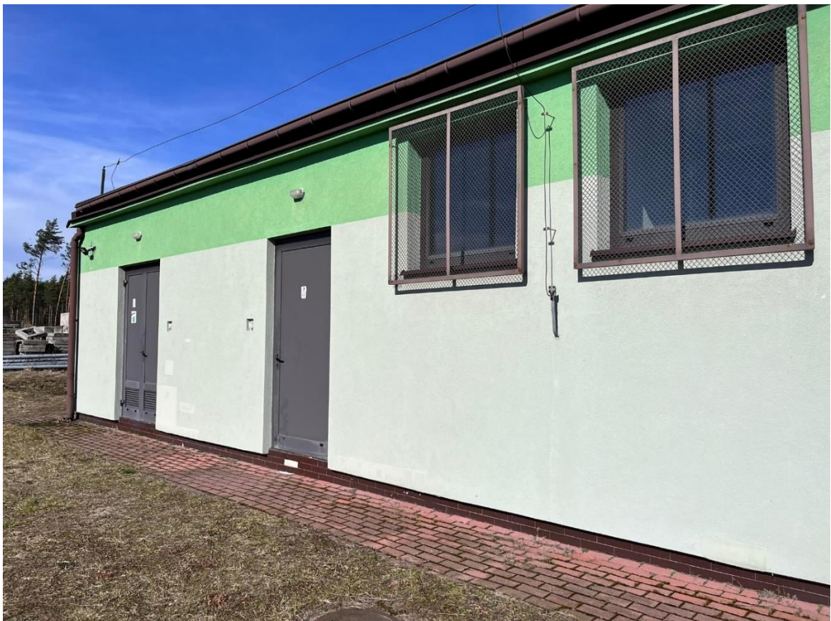
Fot. Elewacja południowa
