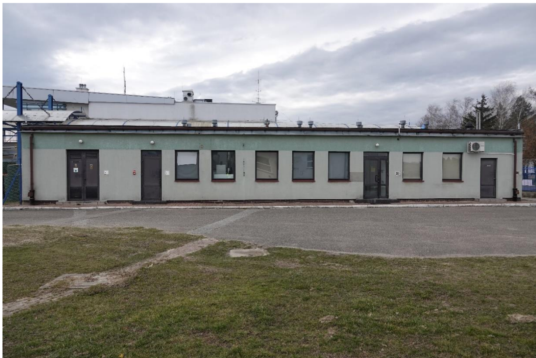
Fot. Elewacja wschodnia
