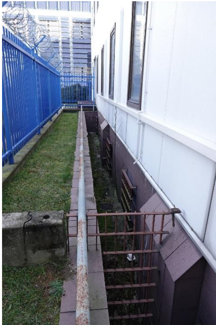
Fot. Wnęka doświetlająca okna piwnic
