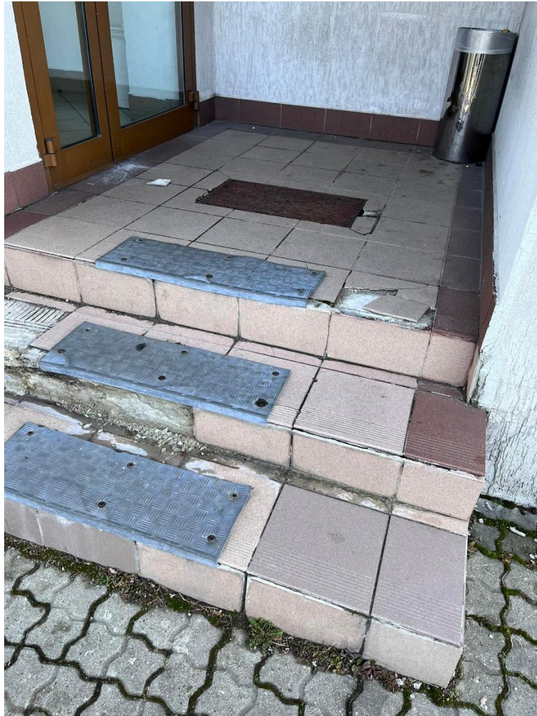
Fot. Schody wejściowe (ściana zachodnia)
