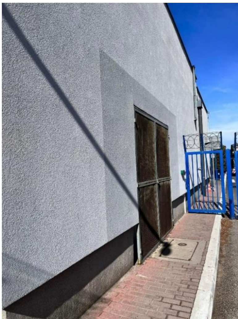
Fot. Elewacja północna cz. 2
