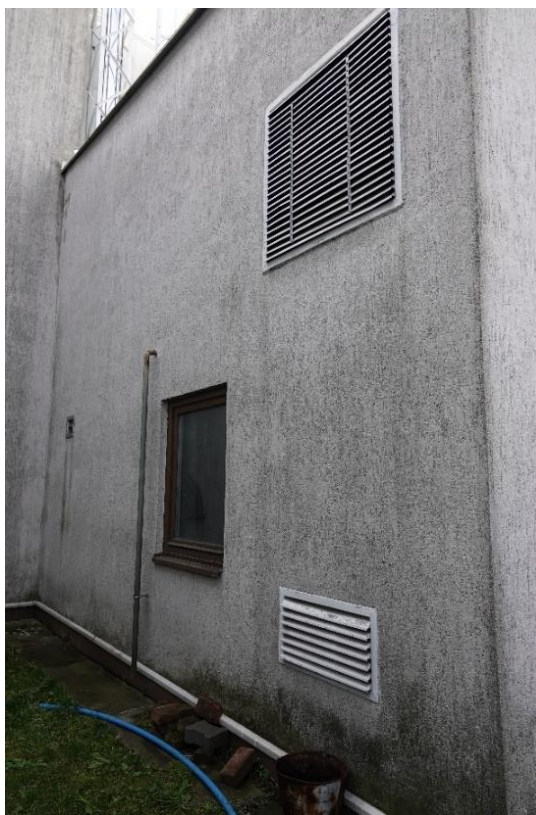
Fot. Elewacja północno-wschodnia cz.1
