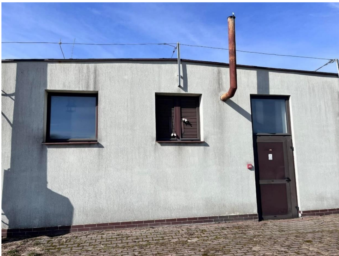
Fot. Elewacja wschodnia
