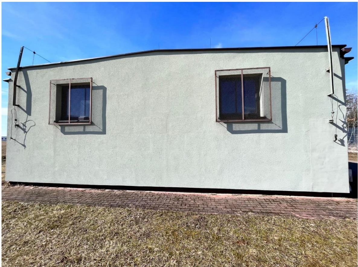
Fot. Elewacja wschodnia
