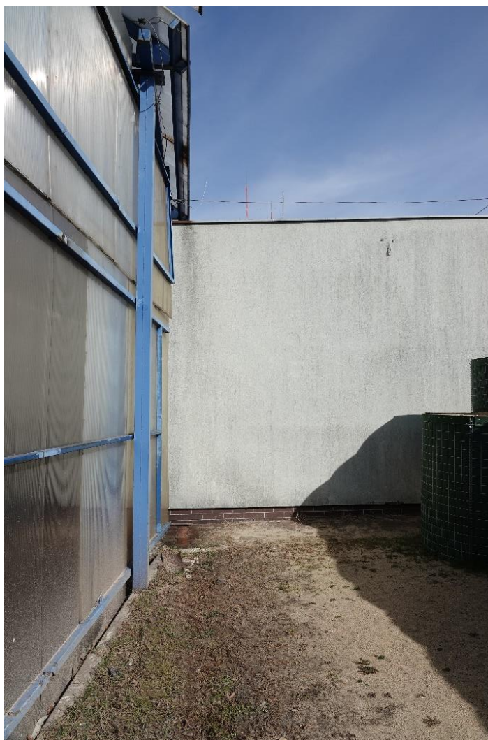
Fot. Elewacja południowa
