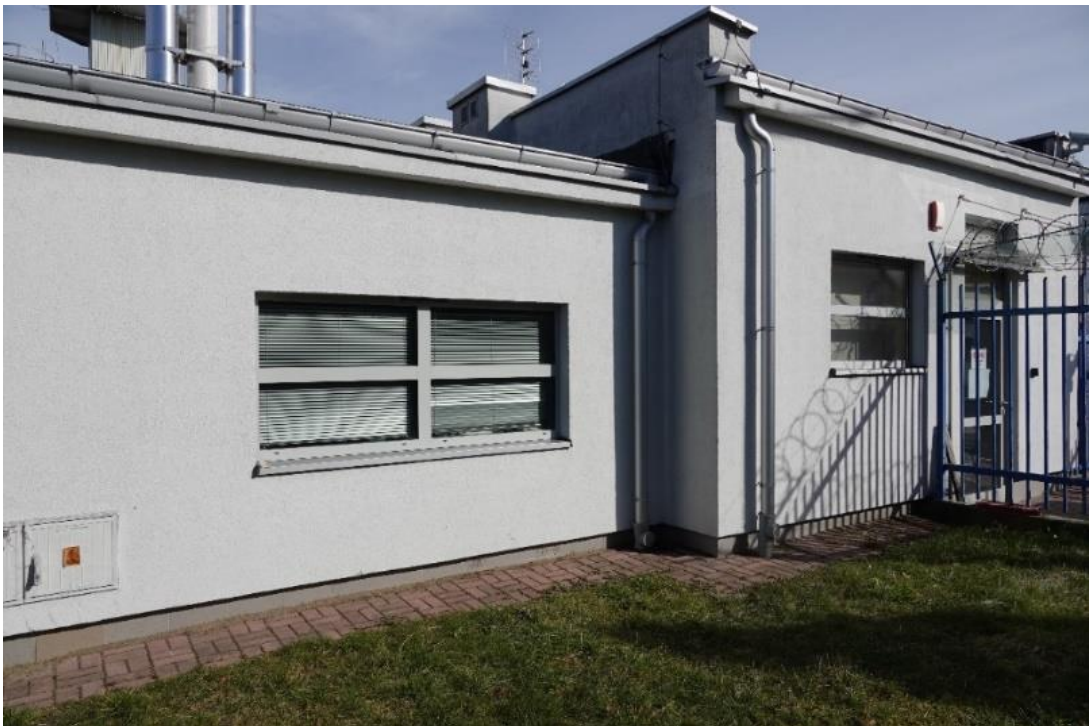
Fot. Elewacja południowa
