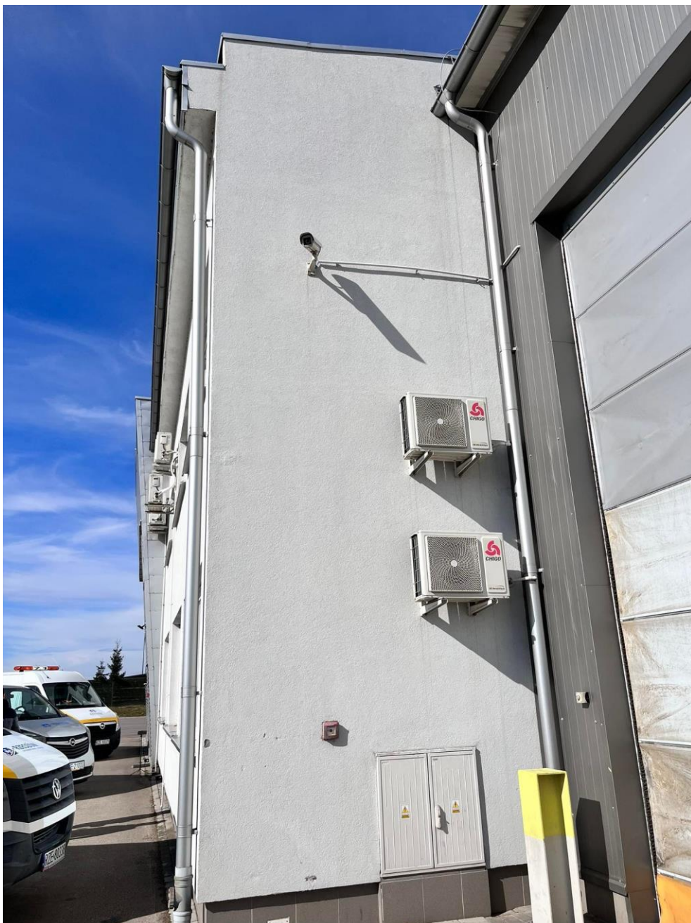
Fot. Elewacja wschodnia
