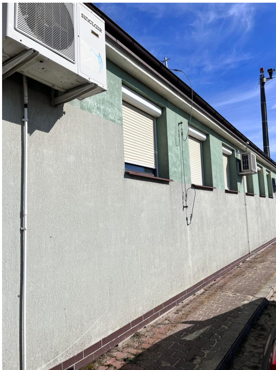
Fot. Elewacja południowa
