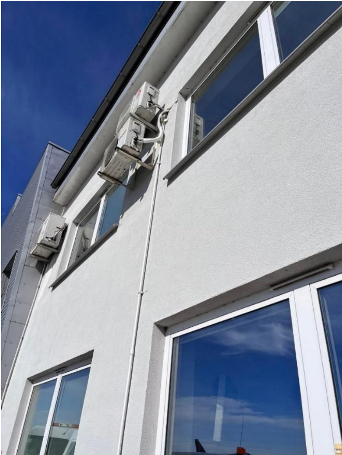
Fot. Elewacja południowa
