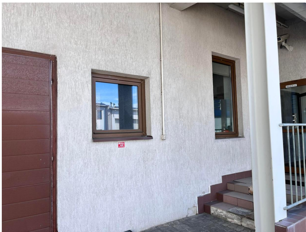
Fot. Schody wejściowe (ściana zachodnia)
