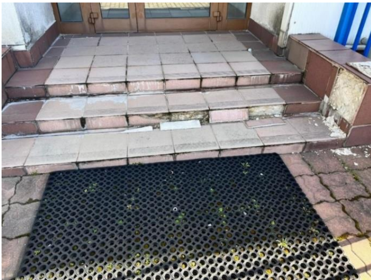
Fot. Schody wejściowe
