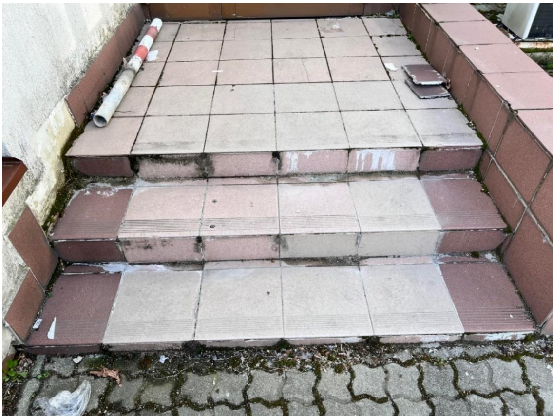
Fot. Schody wejściowe
